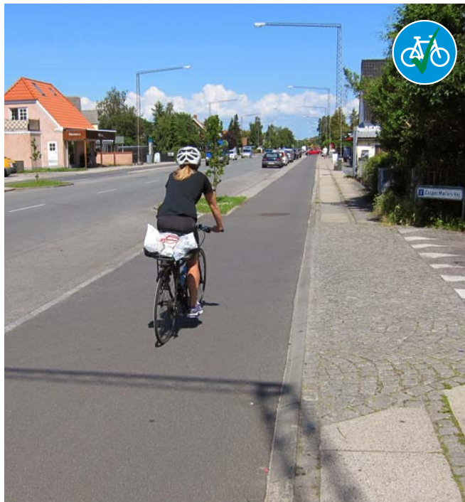
Her er en cykelsti der er ført ubrudt gennem en overkørsel. Udover at sikre god fremkommelighed for cyklister skaber løsningen klare vigepligtsforhold i krydset. ▲
