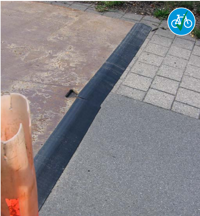
Der findes særlige gummilister til montering i enderne af dækpladerne, som sikrer en blød og komfortabel overgang for cyklisten. ▲
