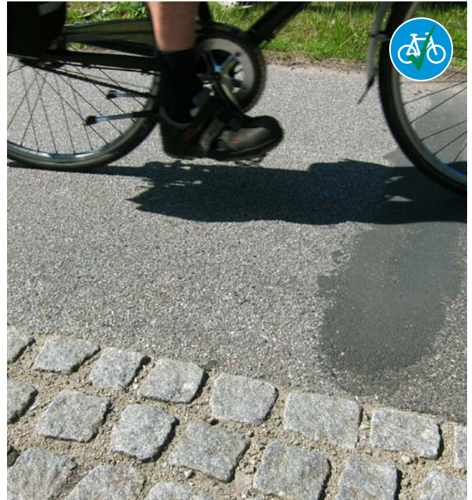
En fin reetablering, udført i niveau med cykelstien og suppleret med et "bitumen plaster", der sikrer en blød overgang fra den gamle til den nye asfalt. ▲
