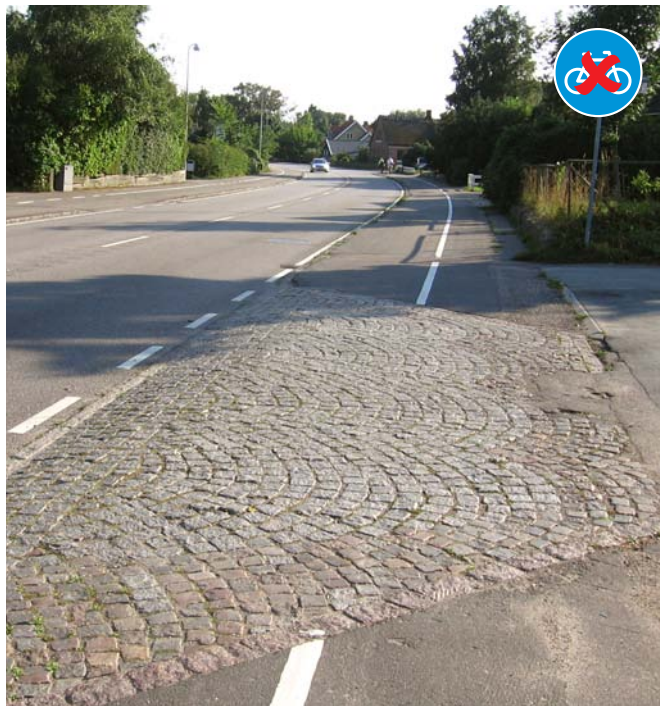
Cykelstier bør føres helt igennem overkørsler med asfalt. ▲
